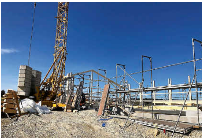
Auch ein Kran war beim Stellen im Einsatz.
