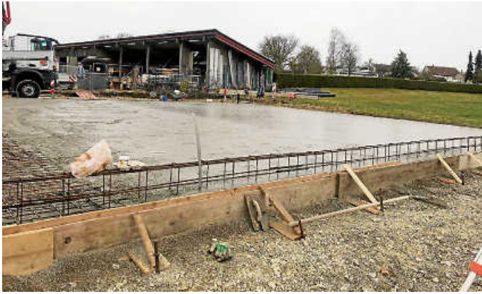
Die Gussform der Bodenplatte von außen Anfang dieser Woche waren nun die Aufrichtarbeiten mit Holz an der Reihe.
