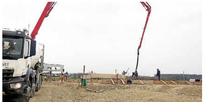
Die Bodenplatte wird gegossen.
