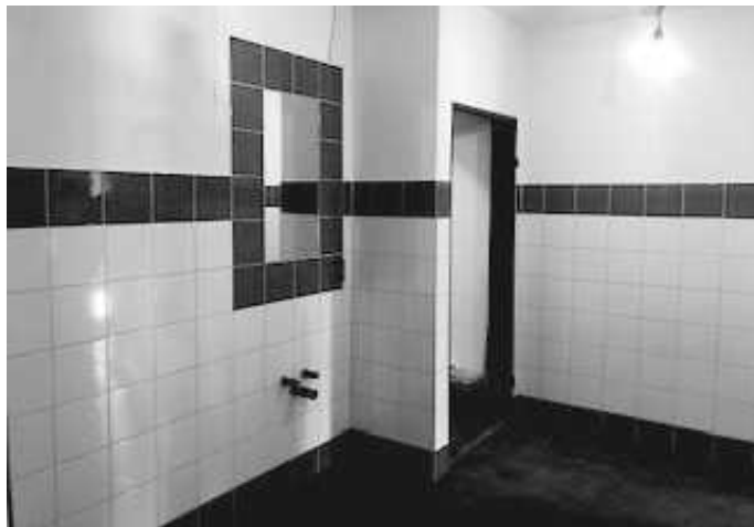
Bereich Waschbecken Umkleide
